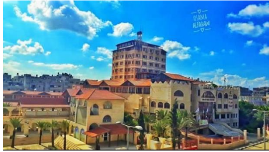
مبنى جمعية الهلال الأحمر الفلسطيني
